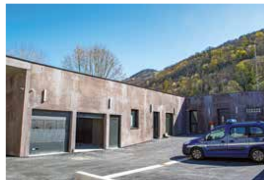
↑ ...à ce jour, travaux presque terminés !
