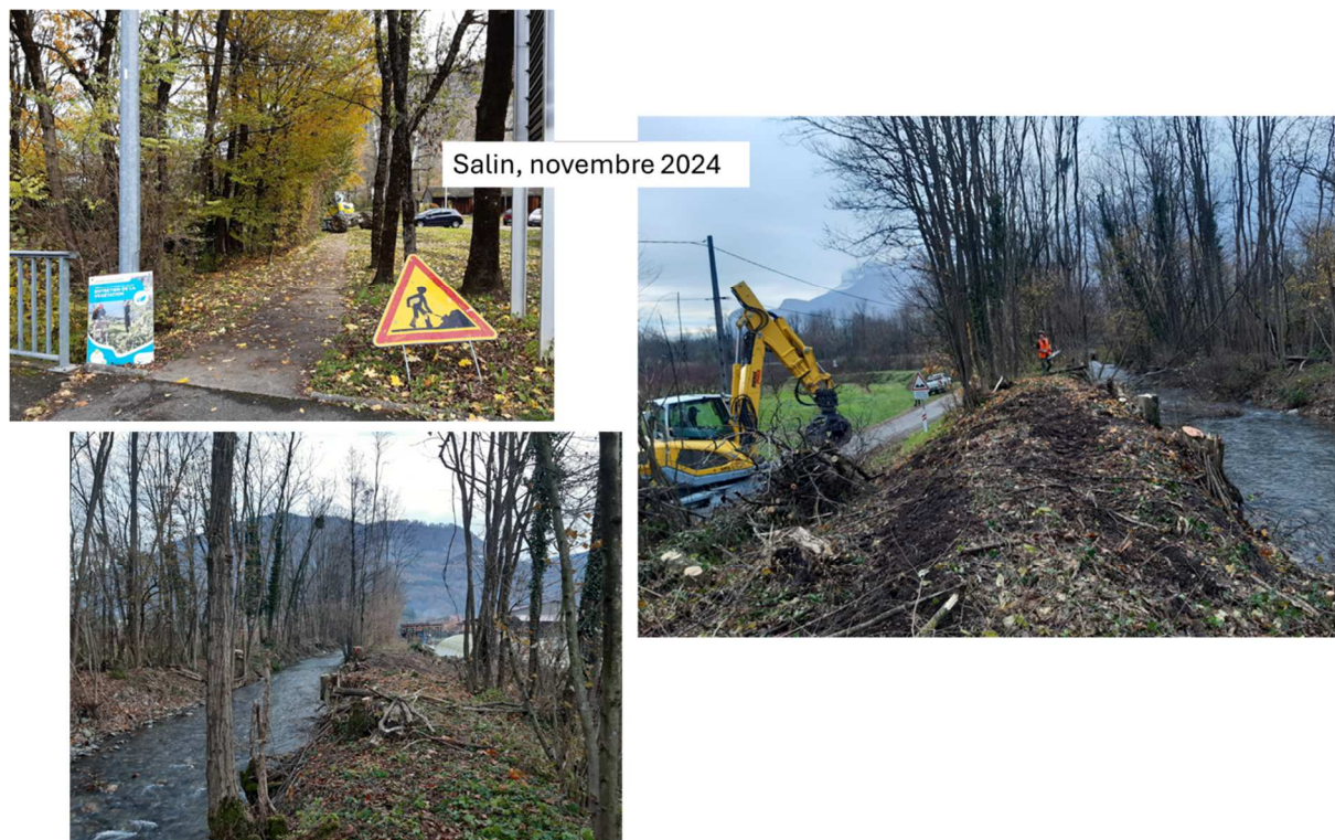
Figure 10 : Intervention sur le torrent du Salin
