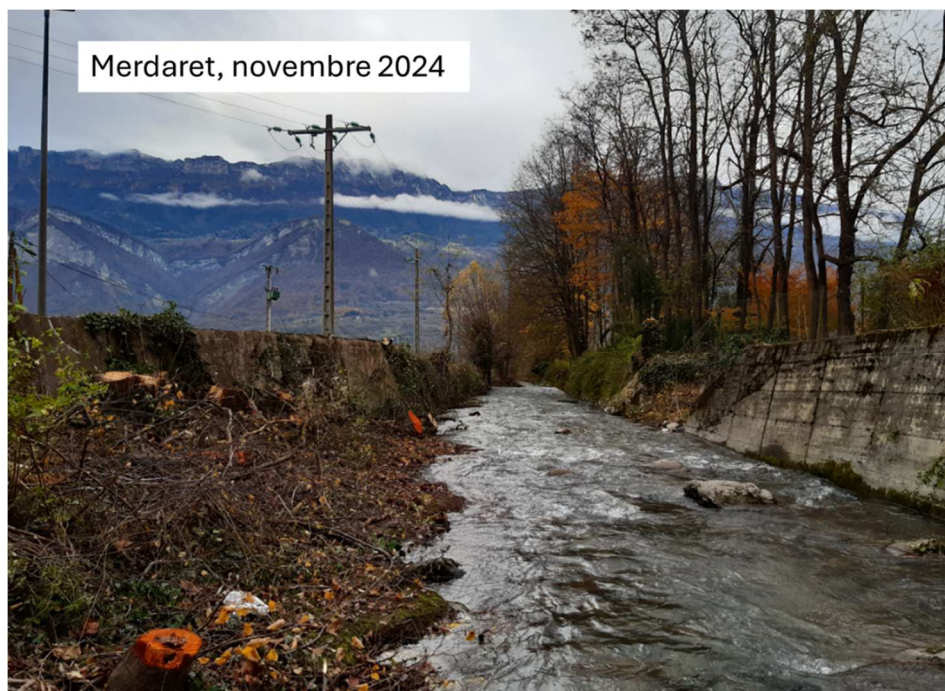
Figure 13 : Intervention sur le torrent du Merdaret
