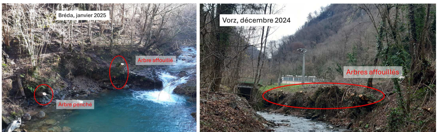
Figure 11 : Interventions sur les torrents du Bréda et du Vorz
