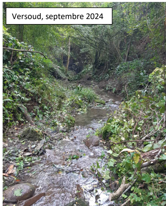
Figure 8 : Intervention sur le torrent du Versoud
