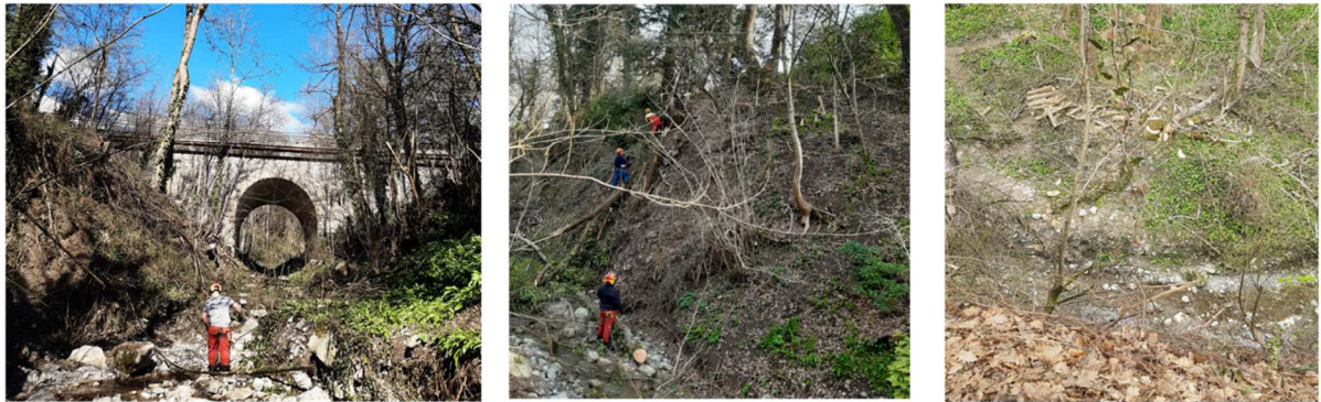
Figure 7 : Intervention sur le torrent du Corbonne
