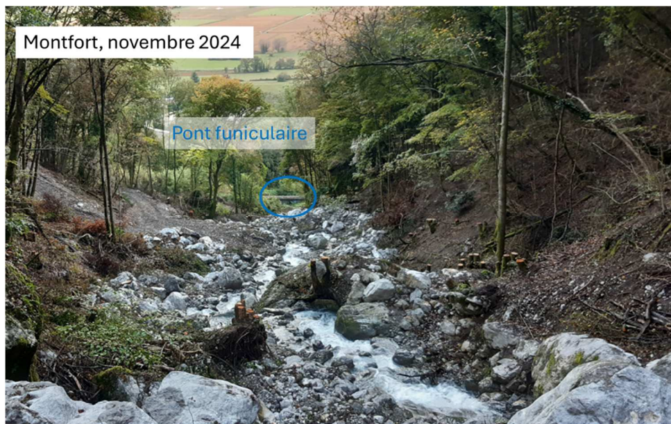
Figure 12 : Intervention sur le torrent du Montfort
